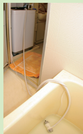
把浴缸里用过的洗澡水，用水泵抽到洗衣机里。
